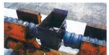
写真4 裏当て材防風フード取付け
