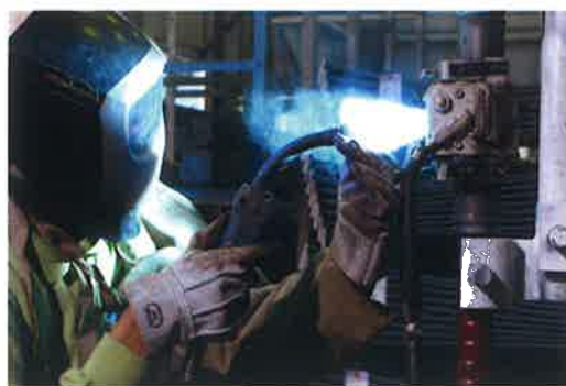
柱筋溶接施工状況
